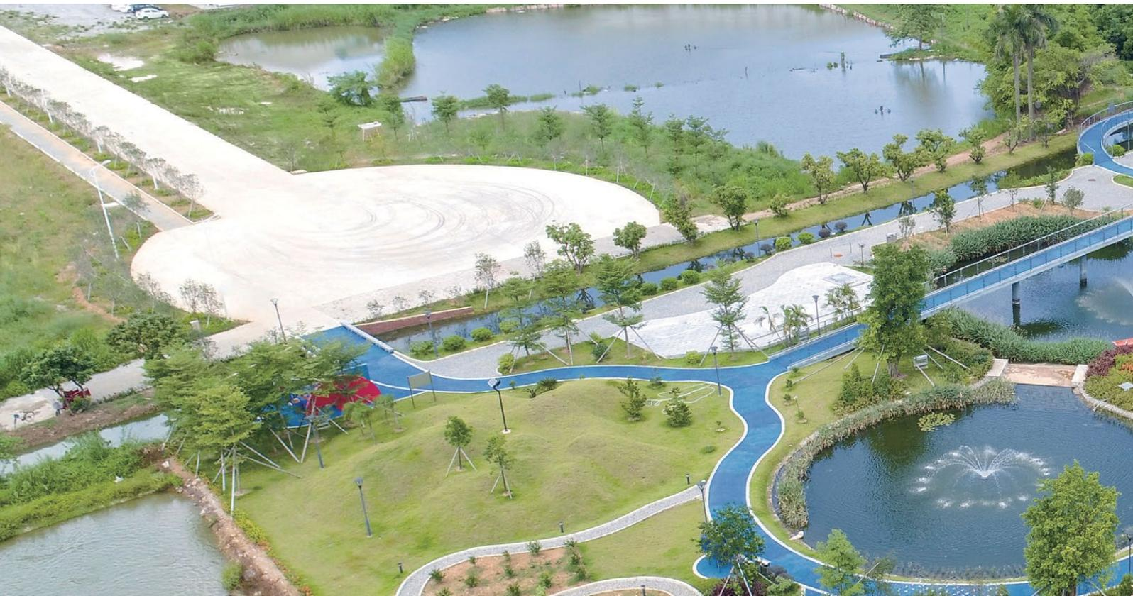
在建築上如何**提高用水效率、污水處理與排放**是LEED另一重要考慮標準。新會生產基地設有污水處理設施、中水回用系統及高效節水器具，可以最大程度節約用水。為了進一步淨化在廠房排放的污水，李錦記正在新會生產基地興建佔地約16,000平方米的人工濕地公園，目前濕地公園的整體結構已大致完成，現正進行植物的培植及系統調試，預計於明年1月正式投入運作。通過在人工濕地種植特定的植物以減少污水中的氮化物，每日的污水處理量達4,000立方米。
